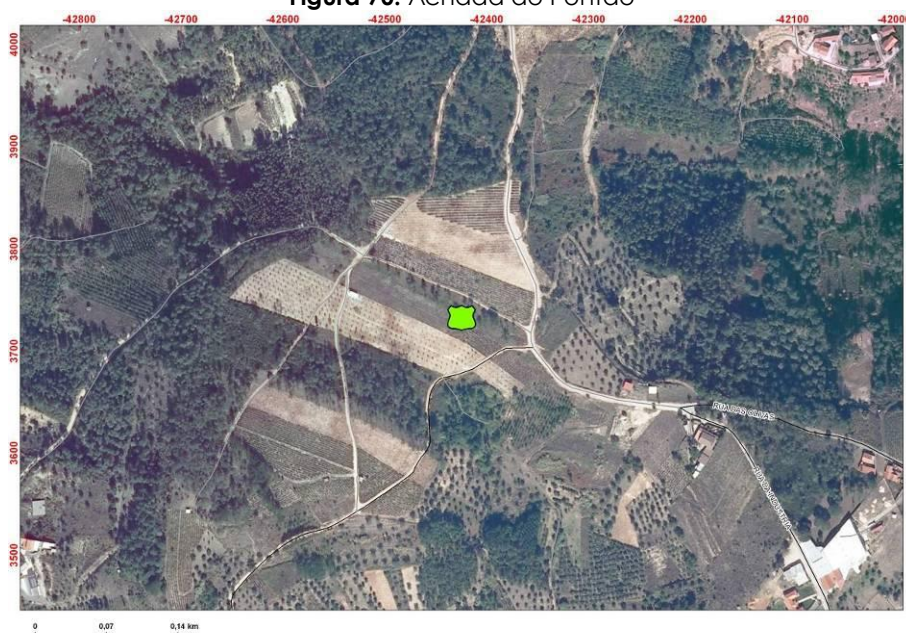
Figura 70: Achada do Pontão
