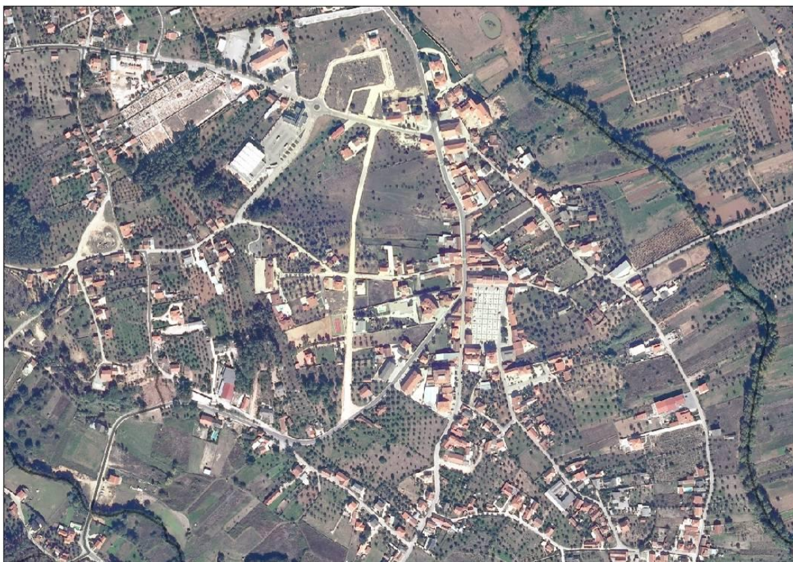
Figura 25: Exemplos de área edificada dispersa de tipo – 3, lugar de Freixianda
