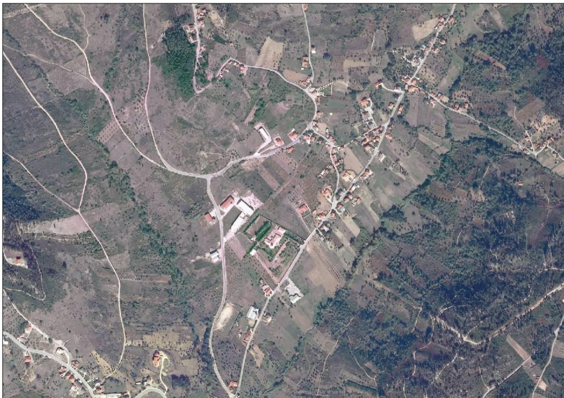
Figura 23: Exemplo de área edificada dispersa de tipo – 1, lugares de Maia e Castelo
