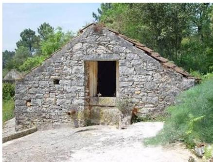
**Descrição:** Cisterna quadrangular com cobertura de duas águas, estrutura de pedra calcária, implantada sobre afloramento calcário.
