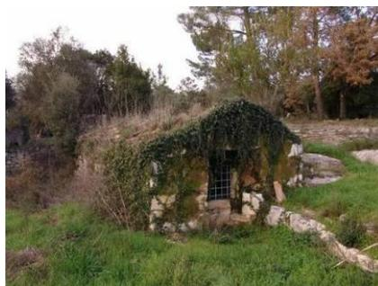
**Descrição:** Cisterna com estrutura retangular de pedra calcária, cobertura de duas águas e um janelo na fachada principal para o acesso à água e para manutenção do interior.
