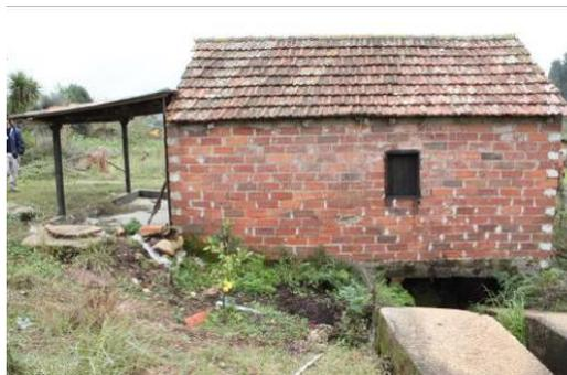
**Descrição:** Edifício de bloco único e volumetria simples, planta longitudinal e cobertura de duas águas; integra um pequeno alpendre avançado. Estrutura com blocos
