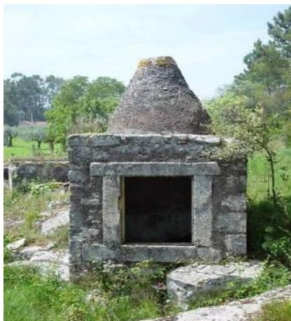
**Descrição:** Cisterna de pedra calcária, de pequenas dimensões, com estrutura quadrangular e cobertura cónica rebocada com argamassa de cal. Envolta em afloramentos calcários.
