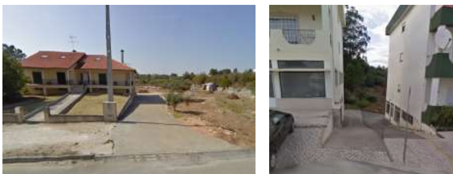
Figura 7: Locais com registo de inundação na cidade de Fátima.
