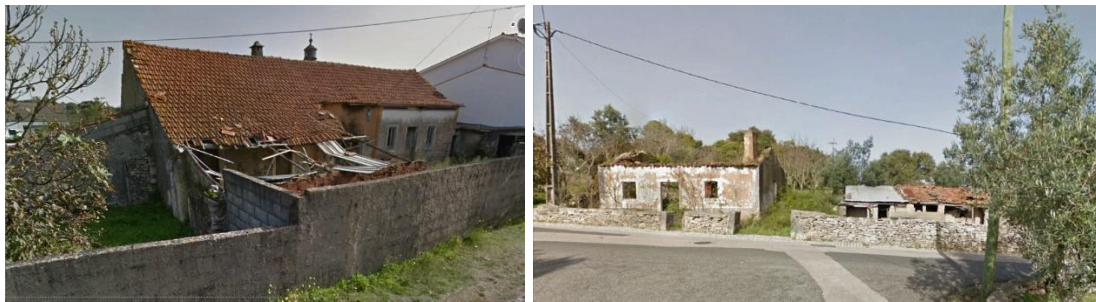
Figura 22 - Exemplos de edifícios residenciais com elementos tradicionais do património arquitectónico, em estado de degradação
