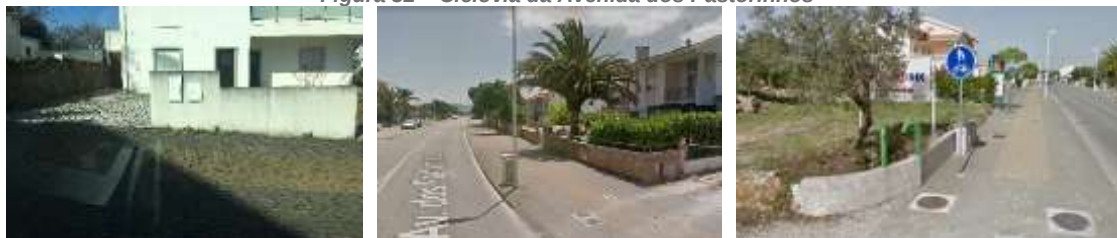
Figura 32 – Ciclovia da Avenida dos Pastorinhos
