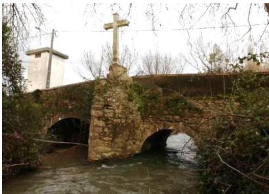
Possui uma estrutura em alvenaria de pedra com o aparelho à vista num dos lados e reboco no outro. Com tabuleiro e dois arcos de volta perfeita. Tem contrafortes de alvenaria de pedra, encontrando-se ao meio da ponte de ambos os lados, bancos de descanso. Na ponte, a montante, está implantado um cruzeiro desde a altura da sua reconstrução, no ano de 1734.
